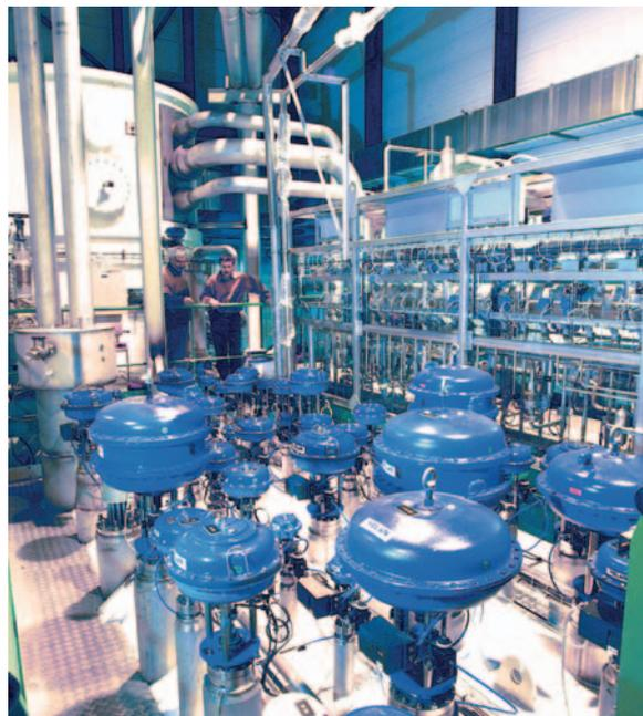
Flüssiges Helium dient dazu, die supraleitenden Magnete des Large Hadron Collider am CERN zu kühlen. Mehrere solcher „Cold Boxes“ bilden dazu den größten „Kühlschrank“ weltweit.
