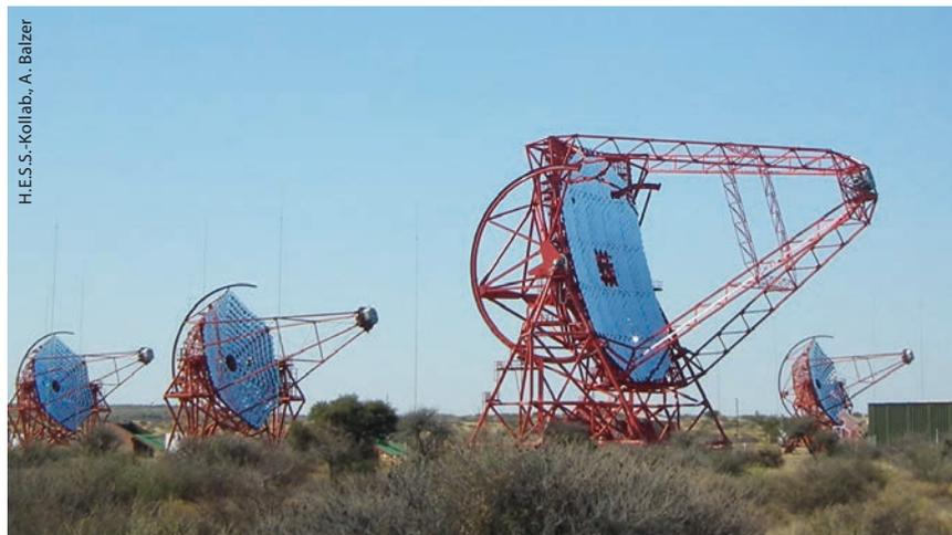
Das H.E.S.S.-System besteht aus vier Cherenkov-Teleskopen mit 12 m Durchmesser, die seit 2004 in Betrieb sind, und dem H.E.S.S. II-Teleskop mit 28 m Durchmesser, das seit 2012 den Gamma-Energiebereich zu kleineren Energien hin erweitert.
