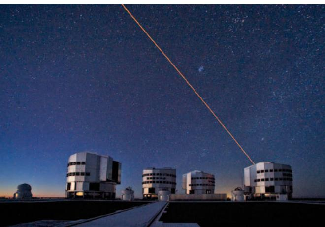
Abb. 1 Am Very Large Telescope der Europäischen Südsternwarte in Chile erzeugt ein Laserstrahl einen künstlichen Stern am Himmel. Mit dessen Hilfe lassen sich Abbildungsfehler, die durch die Atmosphäre hervorgerufen werden, korrigieren.
