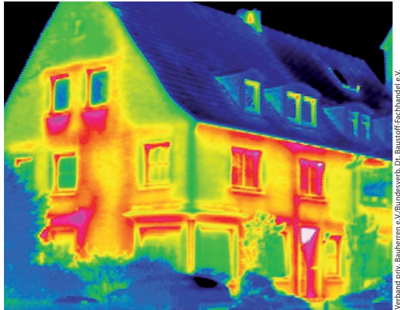
Aufnahmen mit der Wärmebildkamera helfen, Kältebrücken am Haus zu entdecken.
