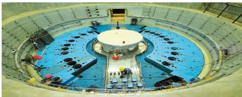
Bei der China Spallation Neutron Source ist das Target aus Wolfram installiert, und das erste Nutzerexperiment hat stattgefunden.
