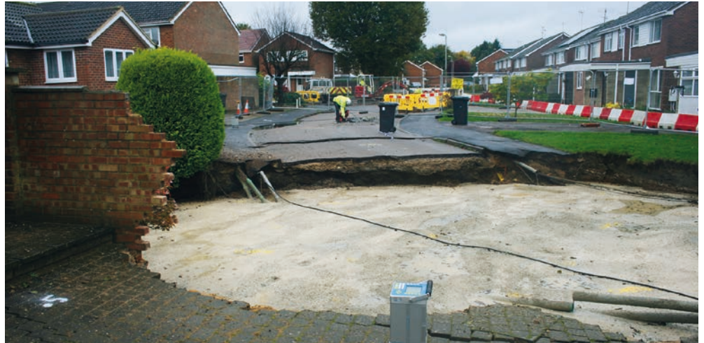
Im Oktober 2015 brach ein zehn Meter tiefes Senkloch in St. Albans, Hertfordshire, auf. Die Betonfüllung sicherte die angrenzenden Häuser, während
