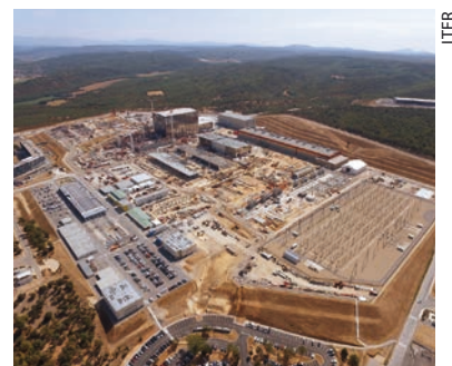
Die Bauarbeiten des International Thermonuclear Experimental Reactor ITER in Cadarache gehen gut voran.
