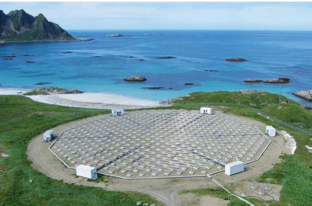
Nicht weit entfernt vom Andøya Space Center und direkt am Meer liegt das 90 Meter große MAARSY-Experiment, das aus über 400 Antennen besteht.
