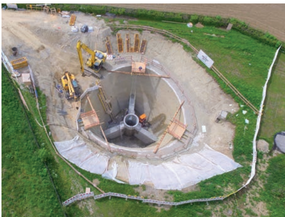
Vergraben in den Feldern von Fürstentfeldbruck befindet sich das Betonfundament für ROMY.
