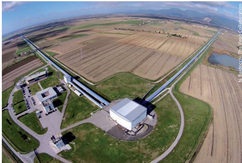
Blick auf das Laserinterferometer VIRGO am European Gravitational Observatory. Am Schnittpunkt der drei Kilometer langen Arme befindet sich das Hauptgebäude mit dem Laser.
