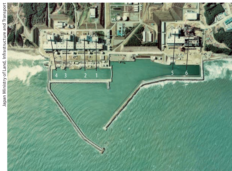
Abb. 1 Das Kernkraftwerk Fukushima Daiichi besteht aus sechs Blöcken, von
