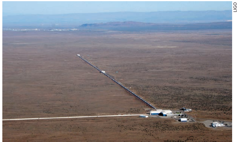
Ein Standort des LIGO-Gravitationswellen-Observatoriums befindet sich in Hanford im US-Bundesstaat Washington.
