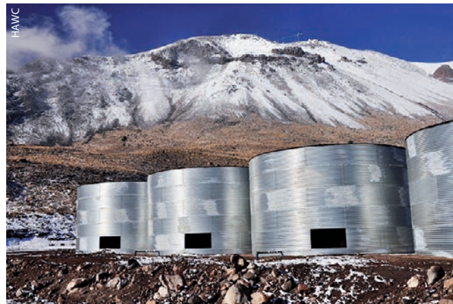
Aus 300 solcher Wassertanks besteht das High Altitude Water Cherenkov Observatory in Mexiko.
