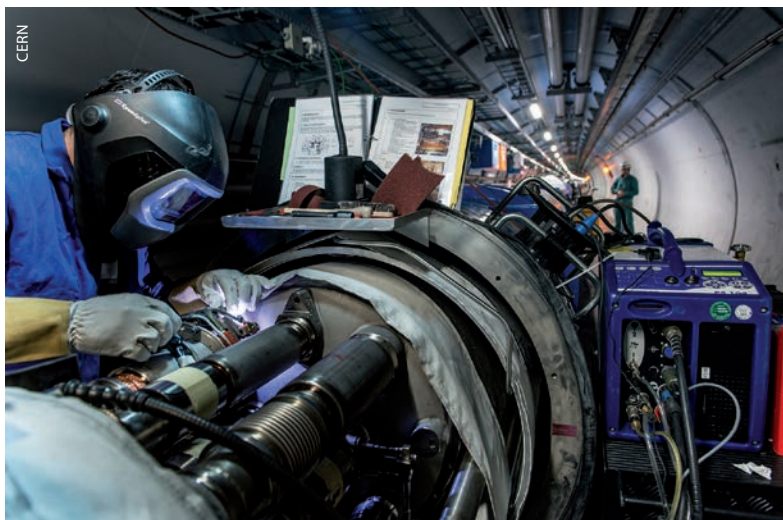
Am LHC wurden sämtliche Verbindungen zwischen den supraleitenden Magneten überprüft.
