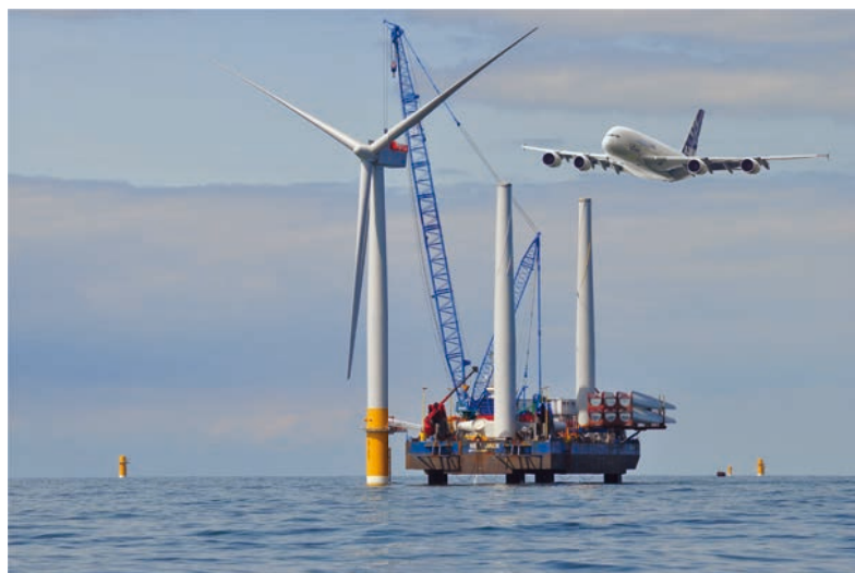
Bei einer Offshore Windenergieanlage der 5-MW-Klasse sind die Rotorblätter 60 Meter lang. Zum Vergleich zeigt die Fotomontage einen Airbus 380, dessen Spannweite 80 Meter beträgt.
