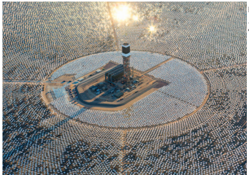
Das Sonnenkraftwerk Ivanpah besteht aus beeindruckenden 300 000 Spiegeln, die auf einer Fläche von 14 Quadratkilometern verteilt sind.
