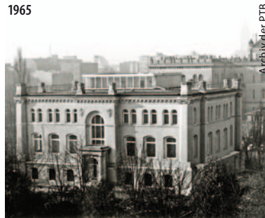
1965 nach der Instandsetzung (Mitte) und heute: Nach der denkmalgerechten Re-
