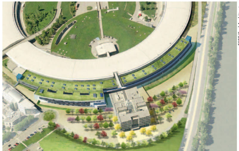
Die neuen Experimentierhallen (mit begrüntem Dach) und das Bürogebäude
