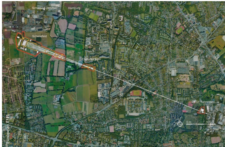
Der European XFEL verläuft vom DESY-Gelände in Bahrenfeld (rechts) nach Schenefeld (links), wo die Experimentier-
