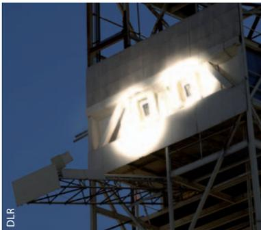
An der erleuchteten Stelle tritt das Sonnenlicht in den Absorber des Solarturms ein.
