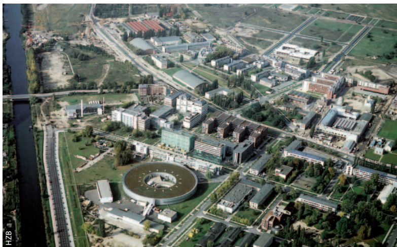
In Berlin-Adlershof befindet sich die ringförmige Synchrotronstrahlungsquelle BESSY II.
