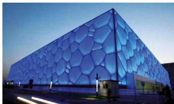
Abb. 5 Die Schwimmhalle für die Olympischen Spiele 2008 in Peking besteht aus 4500 gigantischen Weaire-Phelan-Blasen. Die Struktur, deren Elementarzelle aus vier Blasen besteht, erleichtert mit ihrer Translationssymmetrie die Arbeit der Konstrukteure und macht die Halle erdbebensicherer.
