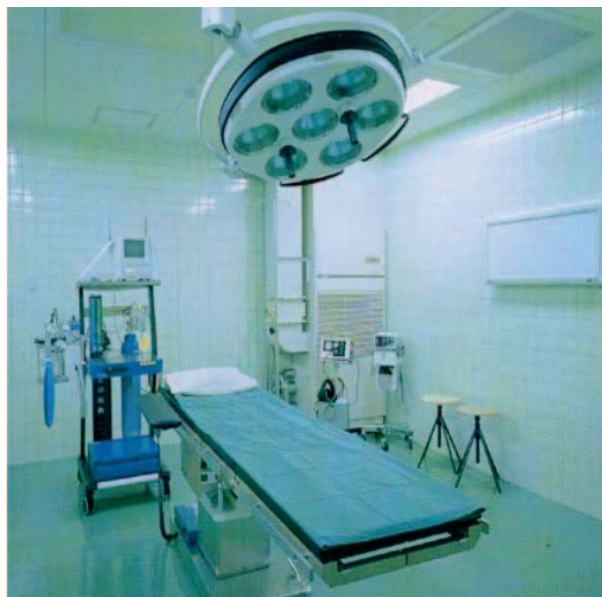
Abb. 5: Die mit \text{TiO}_2 beschichteten Wand- und Bodenfliesen dieses Operationssaals reinigen und desinfizieren sich unter Lichtbestrahlung von selbst (Quelle: K. Hashimoto, University of Tokyo).
