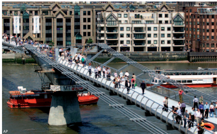
Damit hatte bei der Eröffnung der Millennium Bridge in London niemand gerechnet: Durch die Synchronisation der Fußgänger, die unbewusst in Gleichschritt verfielen, geriet die Brücke dermaßen ins Schwingen, dass sie gleich wieder gesperrt werden musste.
