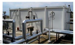
Der Latentwärmespeicher in Almería ist von einer dicken Isolationsschicht umhüllt.
