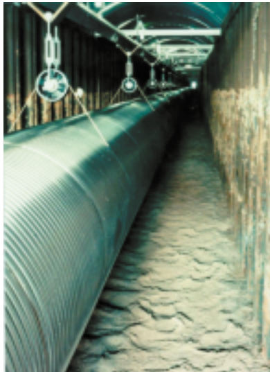
Abb. 5: Die Vakuummrohre von GEO 600 bestehen aus dünnwandigem ( 0,9 \text{ mm} ) gewellten Edelstahl. Sie sind in einem Graben drehbar aufgehängt.
