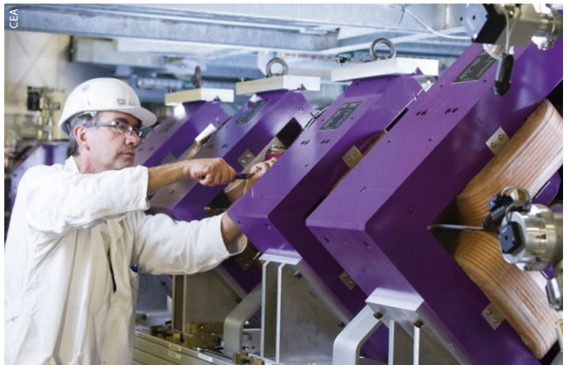
Der im Aufbau befindliche Linearbeschleuniger SPIRAL2 am Schwerionenforschungszentrum Ganil zählt zu den Großforschungsprojekten in Frankreich.
