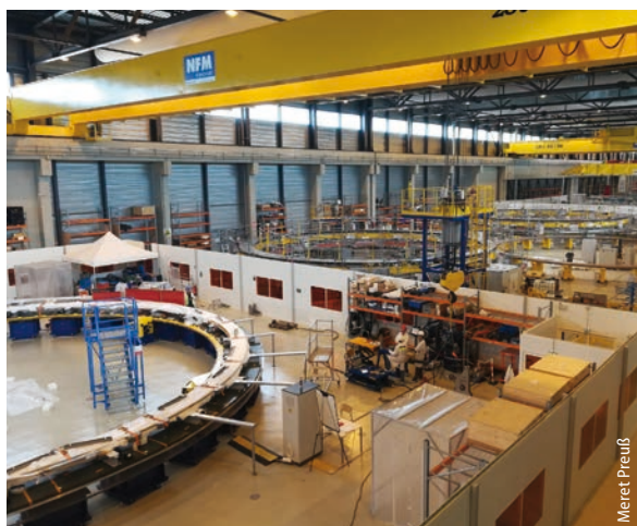
...und machte sich ein Bild vom Stand der Bauarbeiten.
