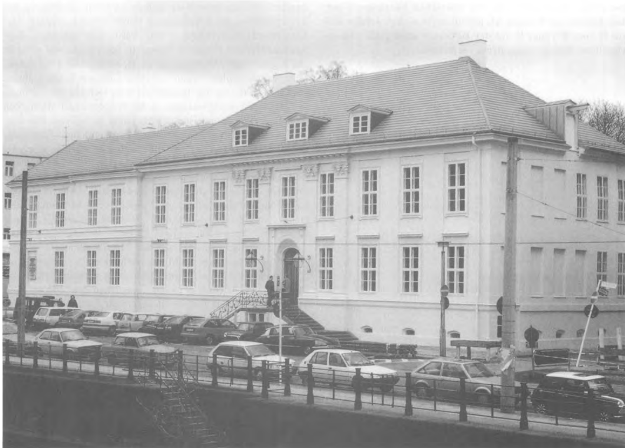
Das Magnus-Haus nach der Renovierung 1994
