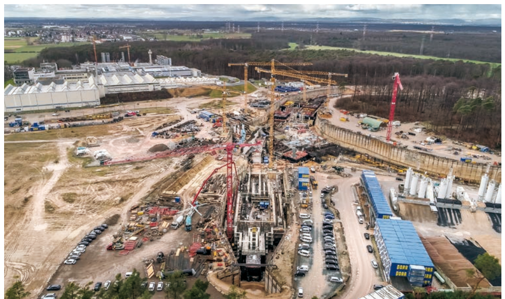
Auf der FAIR-Baustelle schreitet die Entwicklung voran: Rechts ist der nördliche Teil des Baufelds mit dem Tunnel für den großen Ringbeschleuniger SIS100 zu sehen, hinten links befinden sich die GSI-Gebäude.
