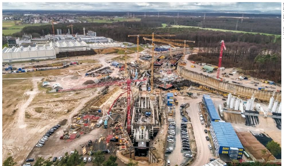
Auf der FAIR-Baustelle schreitet die Entwicklung voran: Rechts ist der nördliche Teil des Baufelds mit dem Tunnel für den großen Ringbeschleuniger SIS100 zu sehen, hinten links befinden sich die GSI-Gebäude.
