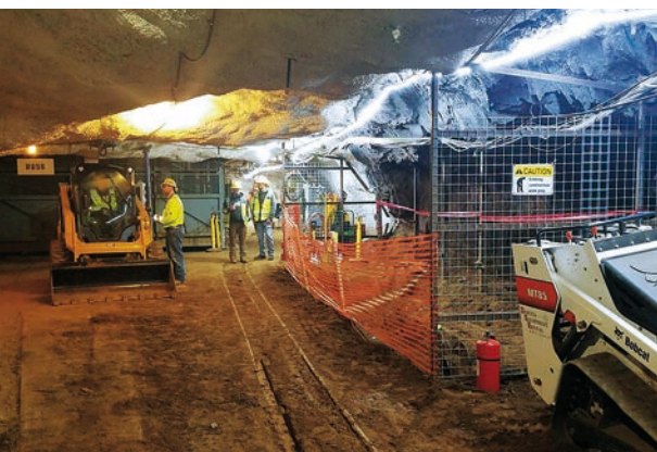
Untergrundarbeiten am Sandford Lab
