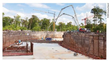
Mit der Betonnage des letzten Abschnitts der Tunneldecke sind die Rohbauarbeiten für den Beschleunigerring SIS100 abgeschlossen.
