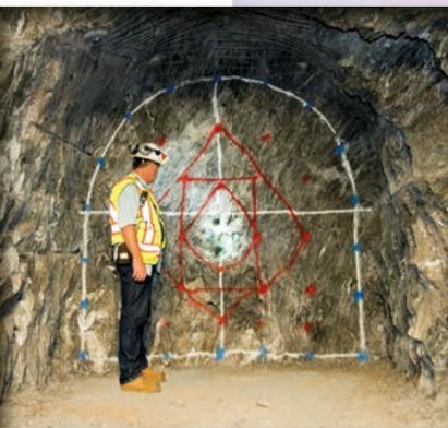
Der riesige ProtoDUNE-Detektor am CERN (oben) dient als einer von zwei Prüfständen für das Deep Underground Neutrino Experiment am Fermilab. Arbeiter richten einen unterirdischen Testsprengebereich für LBNF- und DUNE-Ausgrabungen in der Sanford Underground Research Facility ein (rechts).
