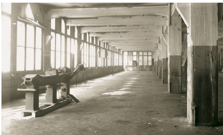
Abb. 2 Diese Halle der Zeiss-Werke in Jena zeigte sich 1947 nach der Demontage durch die sowjetische Besatzungsmacht fast gänzlich geleert.
