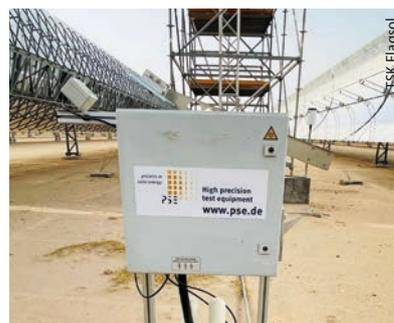
Der Sensor misst die Verschmutzung in einem Parabolrinnen-Kraftwerk in Kuwait.
