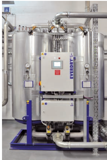
Der Drucklufttrockner Everdry ermöglicht die zuverlässige Abfallsortierung im Recyclingbetrieb.
