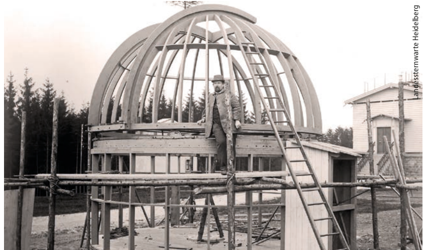
Der Astronom Max Wolf um 1898 auf der Baustelle der Landessternwarte Königstuhl in Heidelberg, deren Bau und Konstruktion er maßgeblich mitgeprägt hat.
