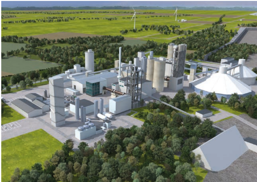
Das neue Projekt GeZero von Heidelberg Materials wird die Zementproduktion im nordrhein-westfälischen Werk Geseke vollständig dekarbonisieren. Der EU-Innovationsfonds unterstützt dieses Projekt.
